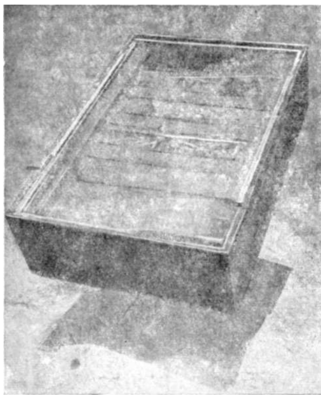
Рис. 8. Конструкция системы И. Г. Трофимова для выплавки серы из руды с помощью солнечных лучей
